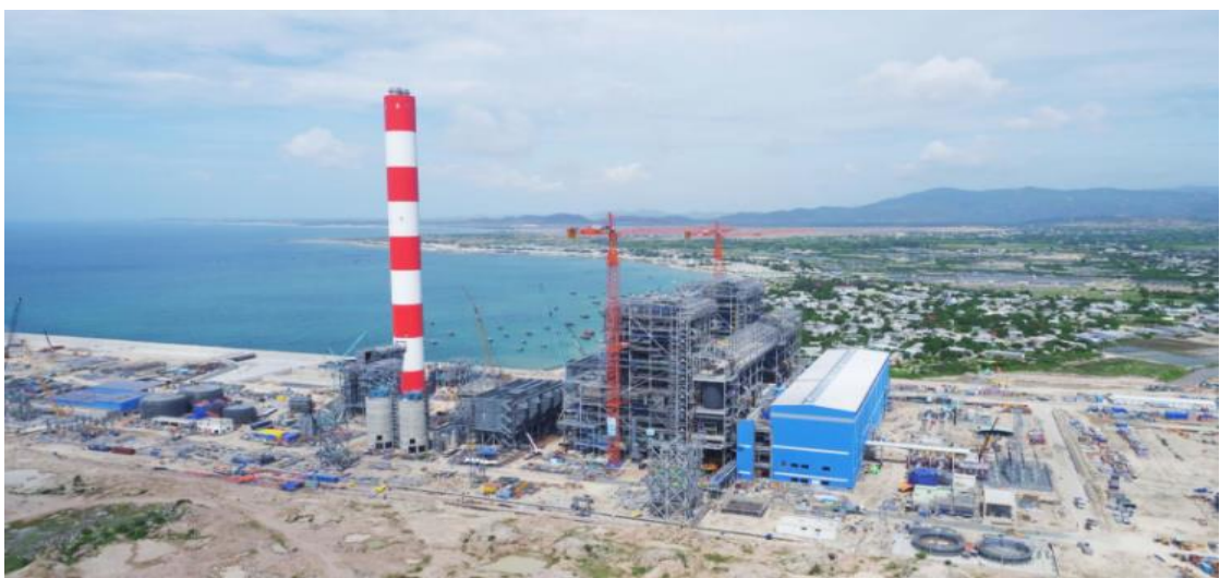
รูปภาพที่ 6 : Vinh Tan 4 Thermal Power Plant
