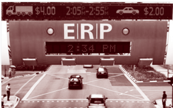
ระบบเก็บค่าผ่านทาง Electronic Road Pricing (ERP) ติดคร่อมบนถนนในสิงคโปร์ แสดงอัตราค่าธรรมเนียม
