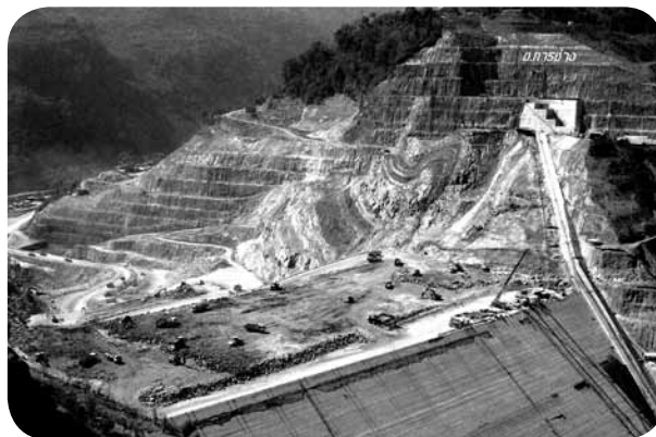
: การก่อสร้างเขื่อนน้ำจั้น 2 ของกลุ่ม ๖. การช่าง ในประเทศลาว
