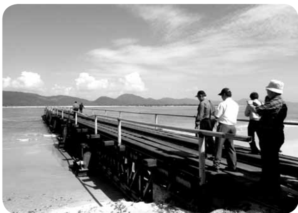
:: ท่าเรือชั่วคราวสำหรับลำเลียงวัสดุก่อสร้างมายังสถานที่ก่อสร้างท่าเรือน้ำลึก และนิคมอุตสาหกรรมทวาย
