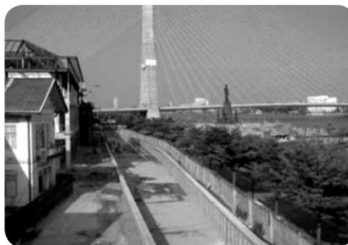
:: เขื่อนป้องกันน้ำท่วมริมแม่น้ำเจ้าพระยา ก่อสร้างโดยบริษัท อิตาเลียนไทย ใต้คอกโปลิย Corrugated Concrete Sheet Pile
