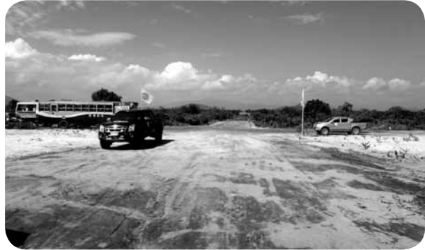
:: ถนนชั่วคราวแบบลูกรังบดอัดภายในพื้นที่นิคมอุตสาหกรรมทวาย
