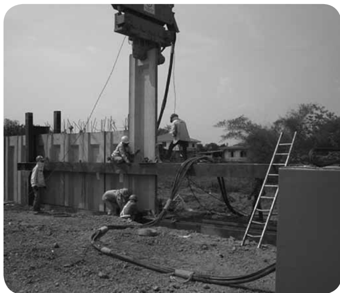
:: การตอกเพน Corrugated Concrete Sheet Pile เพื่อป้องกันอุทกภัยของเขตอุตสาหกรรมนวนคร
