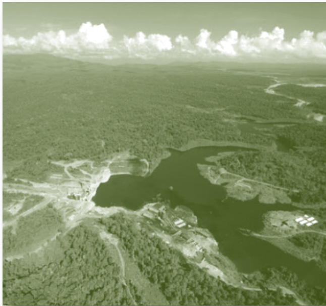
การก่อสร้างโรงไฟฟ้าพลังน้ำเขื่อนอาไต ขนาด 120 เมกะวัตต์
