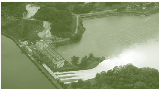
การก่อสร้างโรงไฟฟ้าพลังน้ำน้ำจิม 2 โดยบริษัท ช. การช่าง จำกัด (มหาชน)
