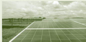
แผงเซลล์แสงอาทิตย์ในเวลาเที่ยงวัน จะหันมุมขนานกับพื้น หรือ "ตำแหน่ง Home"
