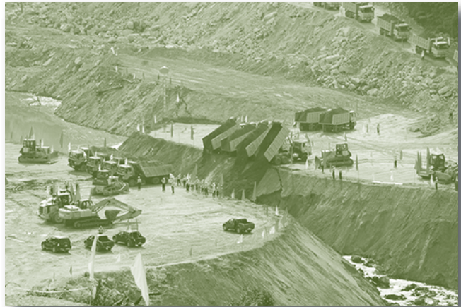
การก่อสร้างโรงไฟฟ้าพลังน้ำเขื่อนตาโต
