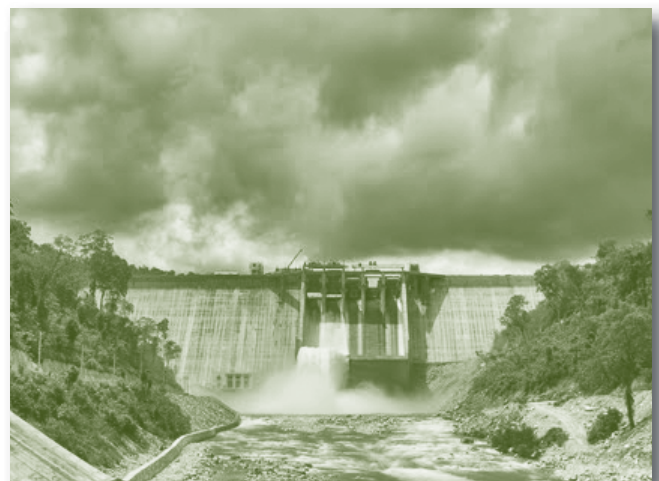
โรงไฟฟ้าพลังน้ำเขื่อนกาจาย ในส่วนเขื่อนหลัก ขนาด 184 เมกะวัตต์
