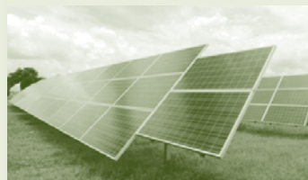
เวลาบ่ายแผงเซลล์แสงอาทิตย์ จะหันไปทางทิศตะวันตก
