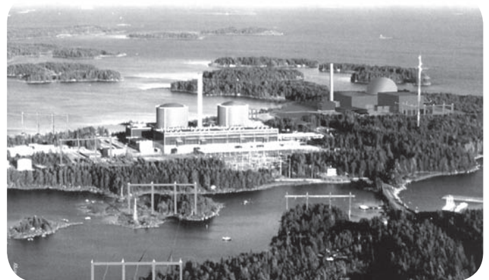
:: โรงไฟฟ้านิวเคลียร์ในประเทศฟินแลนด์
