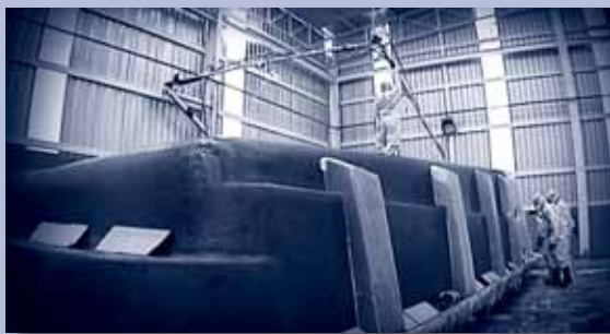
ภายในโรงงานผลิต
