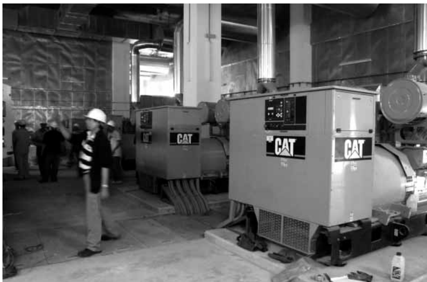
เครื่องกำเนิดไฟฟ้า (Power Generator) สำรองของ Data Center เพื่อรองรับกรณีไฟฟ้าดับเป็นเวลานาน จนทำให้พลังงานไฟฟ้าที่เก็บอยู่ใน UPS ถูกใช้ไปหมด
