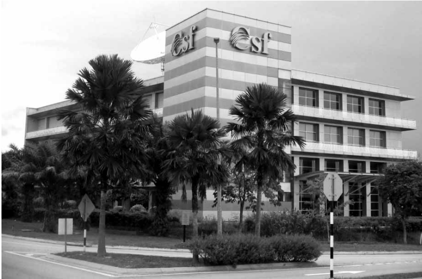
อาคาร Data Center ของบริษัท CSF ตั้งอยู่ที่ Cyberjaya มาเลเซีย
