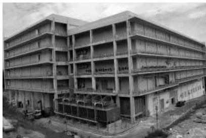
ก่อสร้างอาคารแบบพิเศษโดยมีระบบระบายอากาศและการควบคุมอุณหภูมิเป็นอย่างดี
