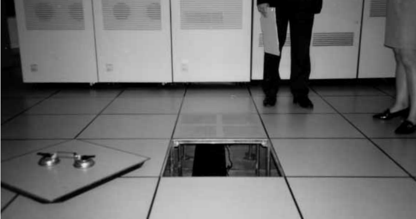
พื้นห้องแบบยกสูง (Raised Floor) ของ Data Center
