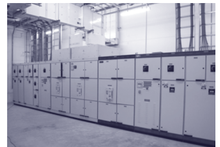
ระบบไฟฟ้าของ Data Center
