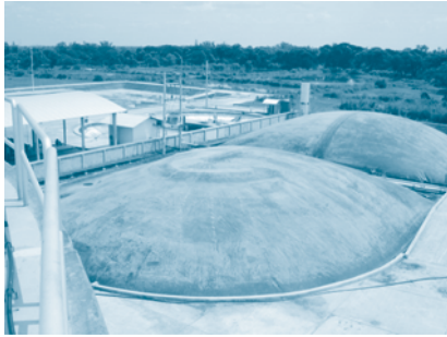
โครงการผลิตไฟฟ้าจากก๊าซชีวภาพ (BIO GAS)
