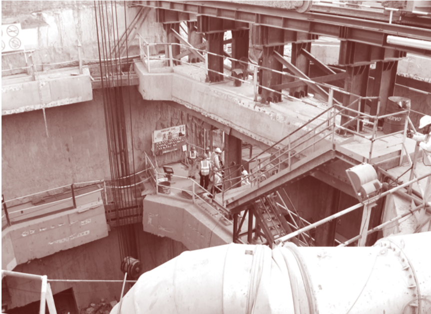
การก่อสร้างอุโมงค์รถไฟใต้ดินในอินเดียของกลุ่มอิตาเลียนไทย
