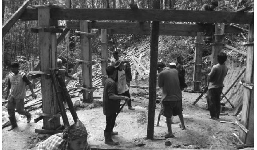
ชาวบ้านช่วยกันก่อสร้างโรงไฟฟ้าพลังน้ำชุมชน
