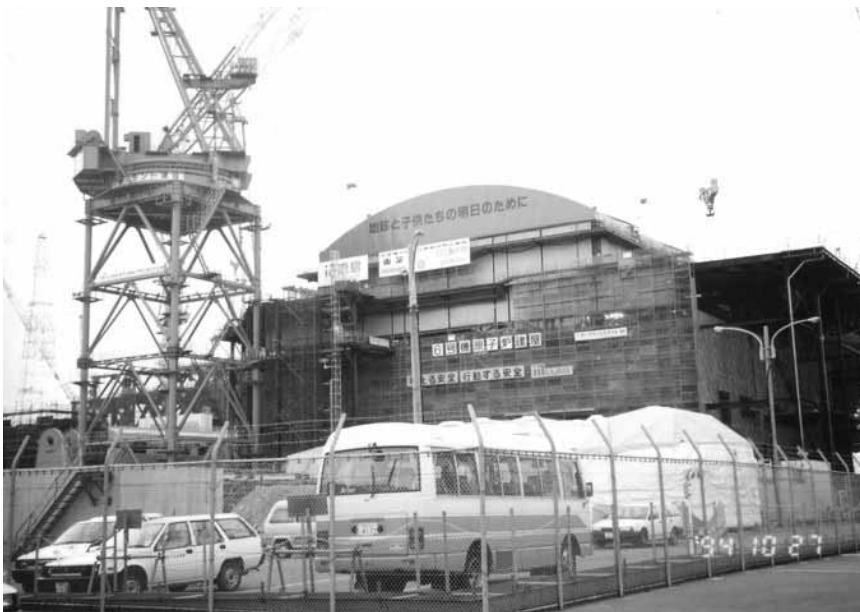
บรรยากาศภายนอกโรงไฟฟ้านิวเคลียร์ Kashiwazaki Kariwa ของญี่ปุ่น ที่กำลังก่อสร้าง
